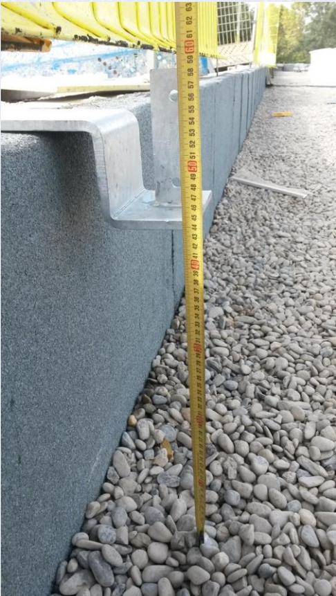
Si une fois posée, la main courante de ce garde-corps en toiture est à moins de 1 mètre du sol, à qui la faute ?
