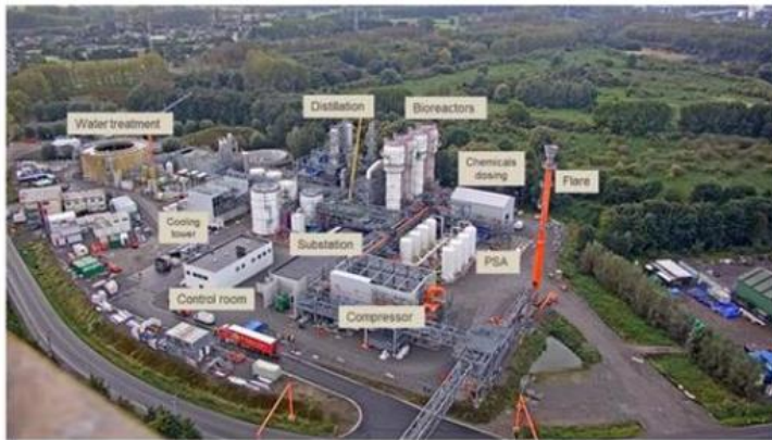
Avancement de l'unité Carbayst® à ArcelorMittal de Gand. Démarrage prévu fin 2022
