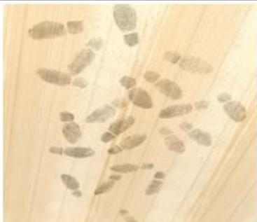
*Exemple* de souillures par traces de pas au plafond destiné à rester apparent.
