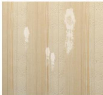
*Exemple* d'une tentative de nettoyage par ponçage de traces de plâtre ou autres projections. Cela rend l'aspect du bois non homogène, il faut éviter de tacher les bois.
