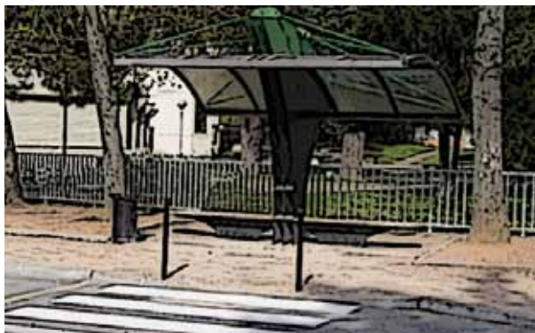
^ L'abribus du lycée Eiffel de Brignais réalisé par les élèves.
