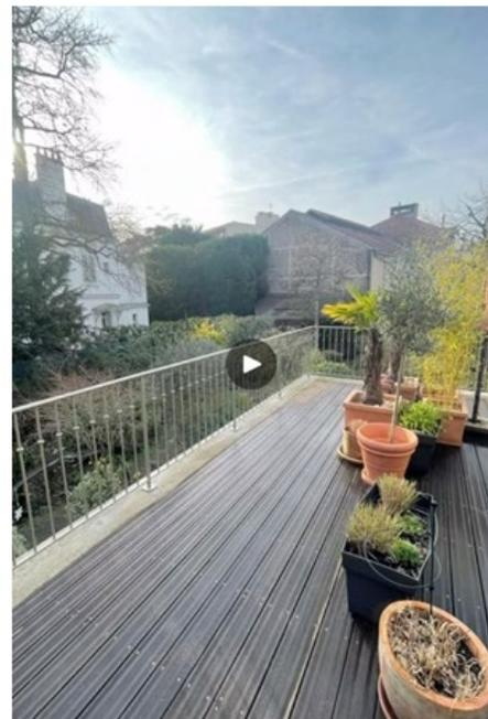
Création, fabrication dans nos ateliers d'un ensemble de garde-corps ,rampe d'escalier et de support de végétation. Conception en fer rond de 16 mm avec une bague d'ornement en fonte . Ossature en...
